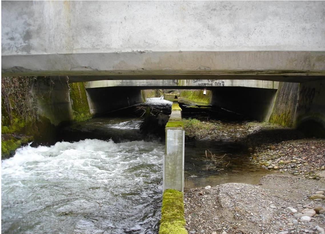
Abbildung 15: Trennwand unter der Autobahnbrücke
