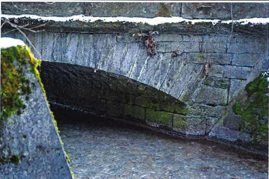
Detailansicht des linksufrigen Widerlagers von der Unterstromseite; sichtbar wird hier auch die Ausführung des schiefen Gewölbes
