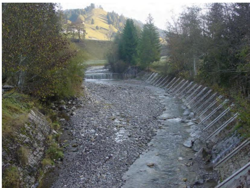
Abb. 4: Betonelemente zur Geschwindigkeitsreduktion an einer Aussenkurve an der Zulg.
