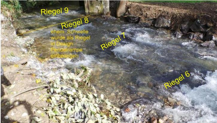
Anschluss an teilabgebrochene Schwelle (Riegel 8)
